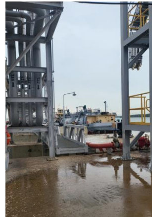
그림 4. 효성화학 베트남 Jetty 및 가압선박 사진
