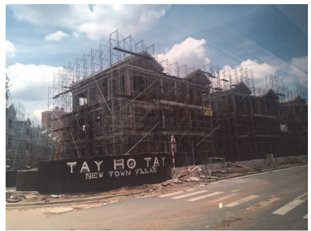
대우건설 THT 현장 전경, 공사가 진행중인 모습
