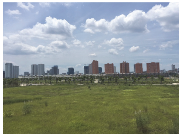
대우건설 THT 현장 전경, 순차적 개발 예정
