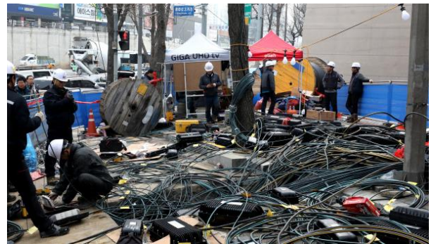
그림 7. KT아현 지사 광케이블 설치 작업 현장
