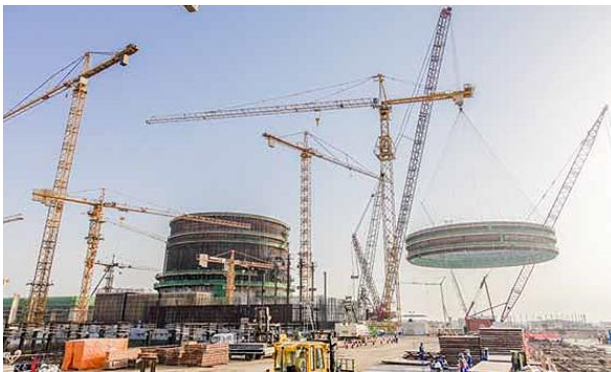
그림3 원자력 BOP 1)CLP(격납용 라이너 플레이트)
