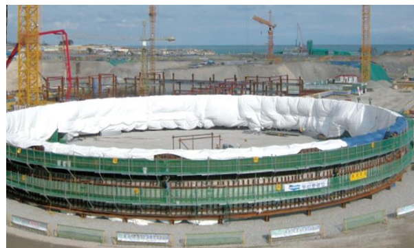
그림4 원자력 BOP 2)SSLW(스테인리스강 라이너 작업)
