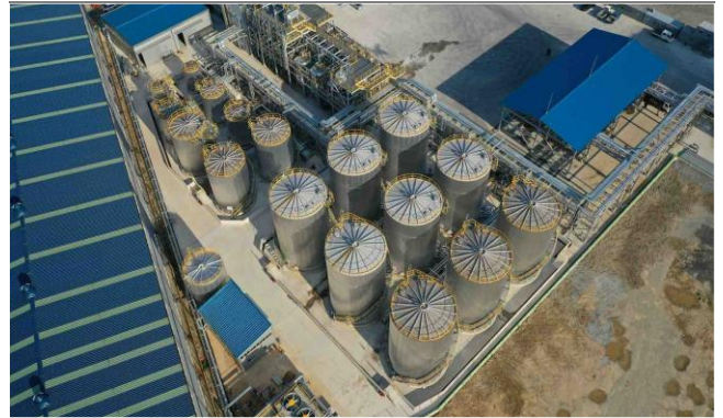
제이씨케미칼의 바이오중유 탱크 터미널
