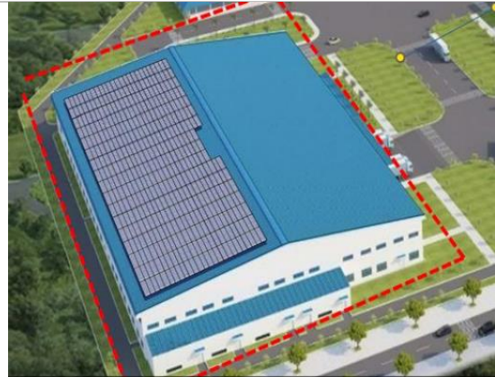
도표 29. 신규 생산 공장의 태양광 패널
