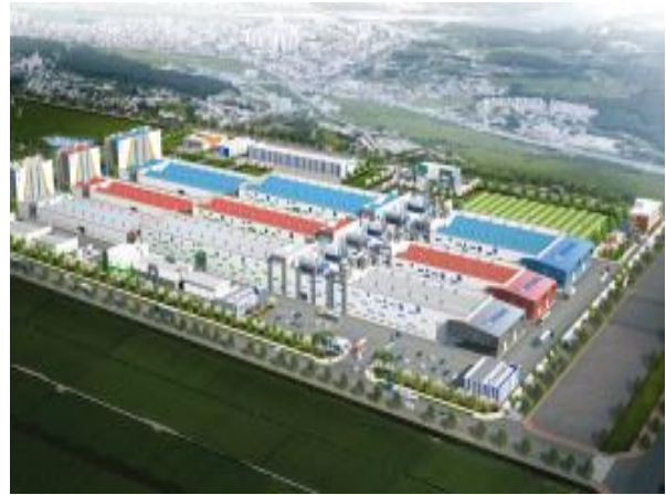
그림 2. 효성첨단소재 전주 탄소섬유 공장 조감도
