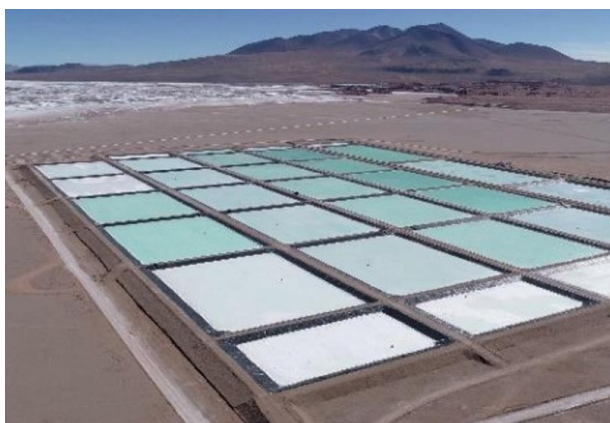
그림3 염수형(Brine) 방식의 리튬 채굴: 증발
