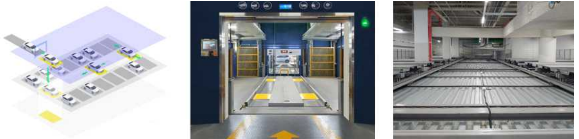
그림 7. 오텍오티스파킹시스템의 평면왕복식 주차설비 예
