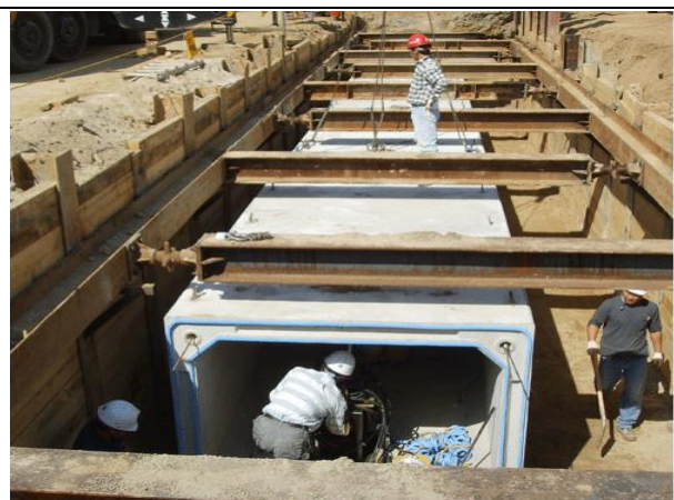
그림6. PC BOX 시공 전경
