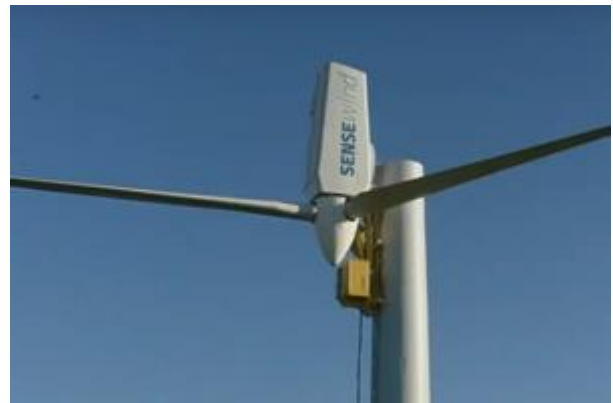
그림8 Climbing 방식의 설치모습
