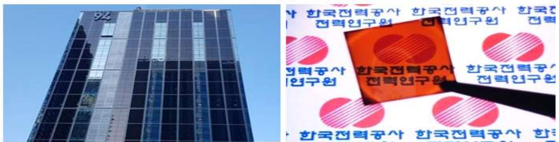
그림 12. 건물 일체형 태양광을 적용한 건물(좌)과 3세대 페로브스카이트 태양전지(우)
