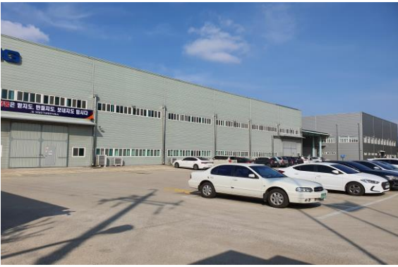
도표 1. 대양전기공업 방산 및 철도 사업장 전경
