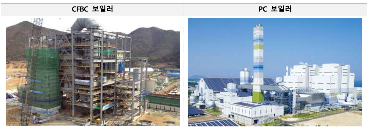
[그림 10] CFBC 및 PC 보일러 설치 현장
