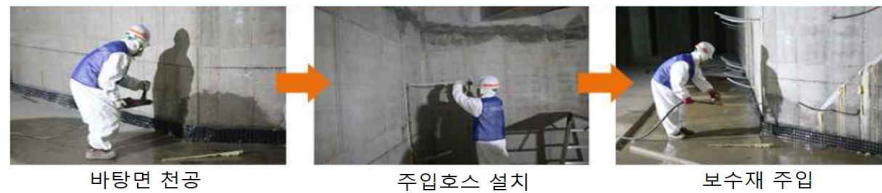
그림 4. 누수 보수공법 신기술의 시공절차 및 방법
