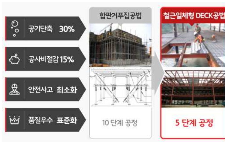
[그림 7] 한판 거푸집 공법과 철근일체형 DECK 공법 비교
