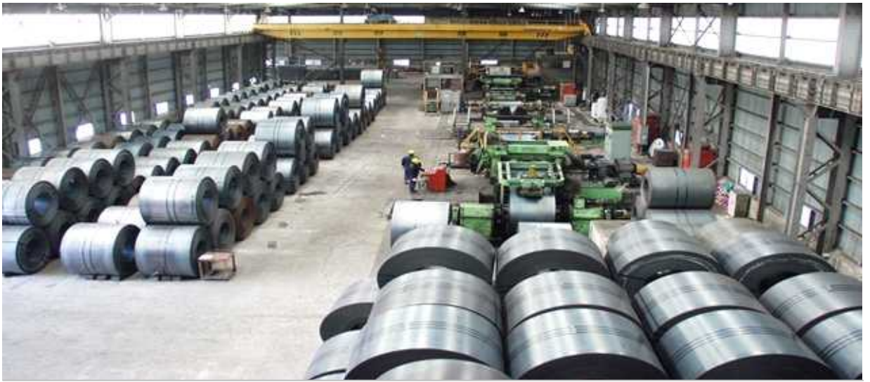
[그림 12] 포항 제1공장 6mm Shearing Line
