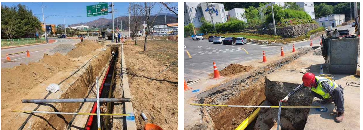
[그림 15] 산청군 도시가스 공사 현장
