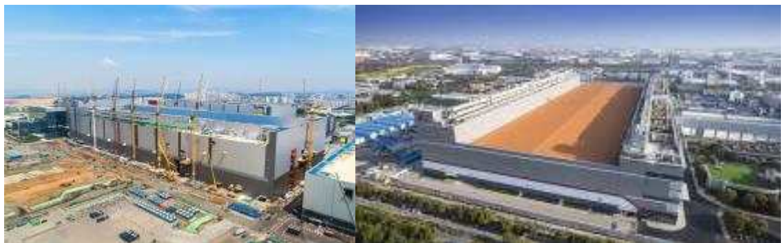
그림 9. 삼성전자 평택 공장, SK하이닉스 우시(중국) 공장
