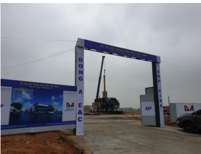
도표 17. 베트남 2법인 건설 현장 (ARP VINA)
