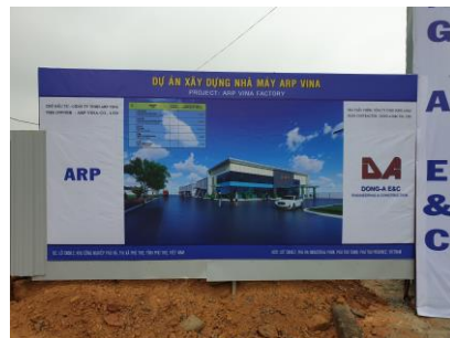
도표 18. 베트남 2법인 건설 현장 (ARP VINA)
