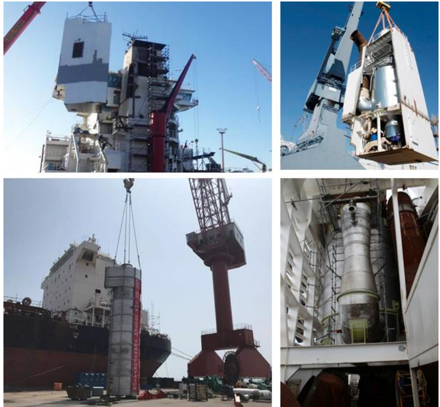
그림32. 기존선에 Scrubber Retrofit 중인 모습
