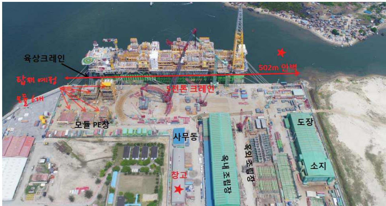
〈도표6-2〉 SHI-MCI 전경: 502m 안벽과 최신 자재창고 등, 서아프리카 최고 Offshore 물류기지 및 로컬 제작사로 거듭날 듯
